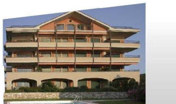
Palazzo realizzato in Legnobloc – fronte lago Luglio\2011
